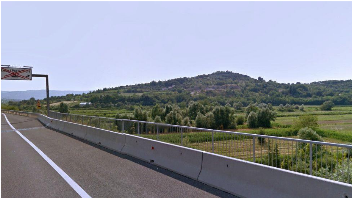
Slika 10.5: Sedanji pogled na kmetijske površine, ki je po sprejetem Državnem prostorskem načrtu namenjen za skladišča Luke Koper, ki skromne dobičke ustvarja na račun tovarnega tranzita po železnici, ki ne plačuje uporabnine za tire. Torej služijo na račun davkoplačevalcev.
